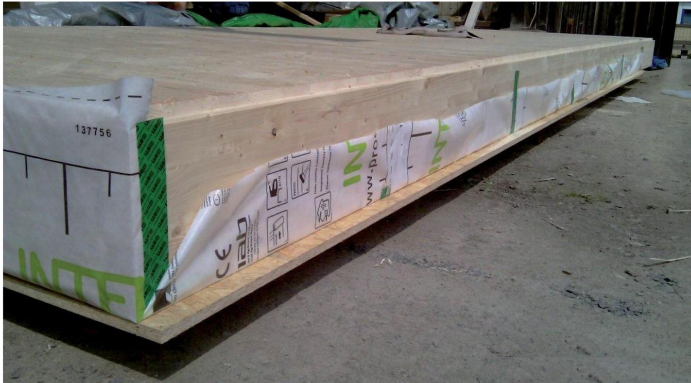
\_zwischen den Bindern lagern vorgefertigte Dachelemente aus 8/32cm Balken (e=83cm)
