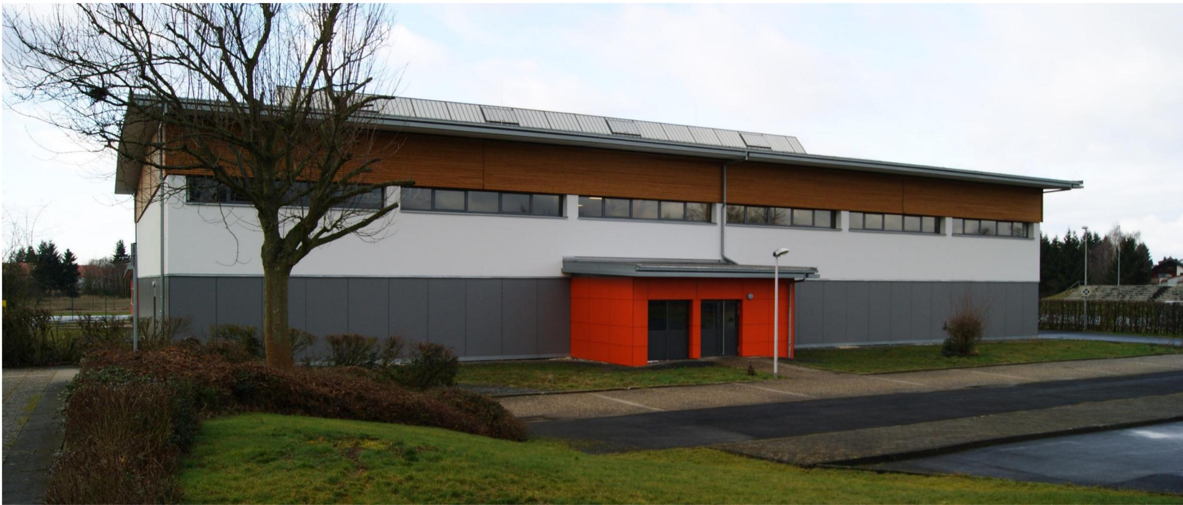
\_ U-Wert der Dachkonstruktion  $U = 0,13 \text{ w/m}^2\text{K}$
