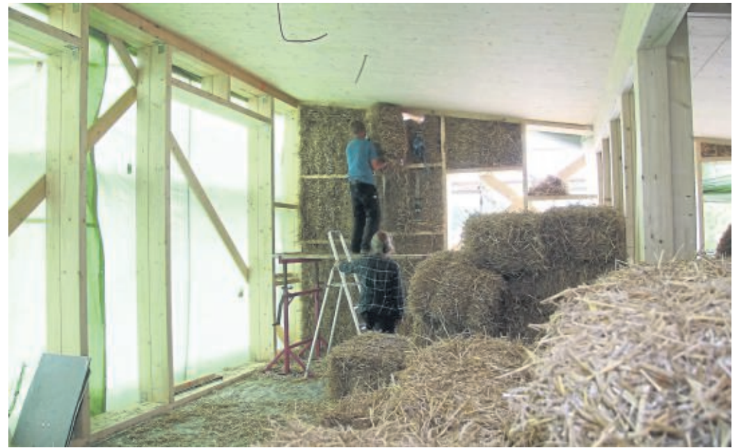
Einsetzen und verdichten: Die Strohballen werden in die Holzkonstruktion geschoben und dann verdichtet. Ganz links sieht man schon die Öffnung für die drei Meter hohen Fenster.
