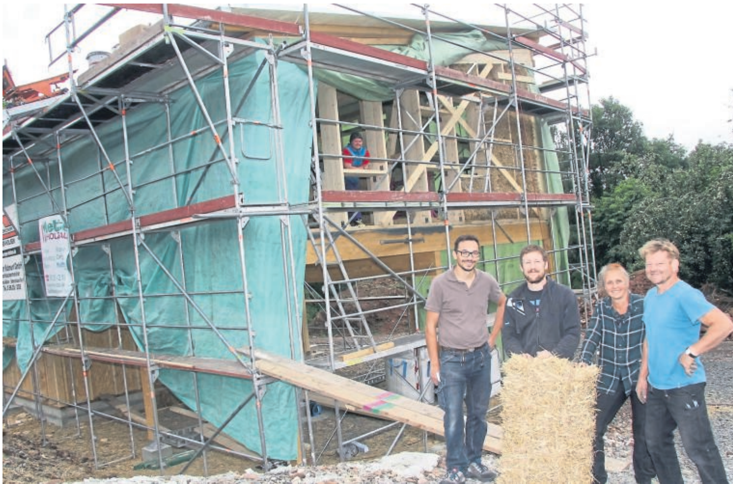
Eigenheim aus Holz und Strohballen: (von links) Dipl.-Ingenieur Sebastian Mette, Bauherr Dominik Bruchmann, Architektin Andrea Herbst und Architekt Ulrich Bräuning aus Grebenstein.
