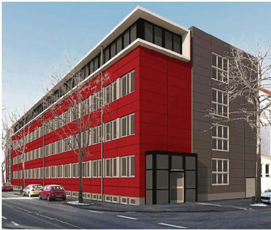
So soll es werden: Die Fassade des Gebäudes wird mit roten Glaselementen hergestellt. Das fünfte Geschoss wurde bereits aufgesetzt.
